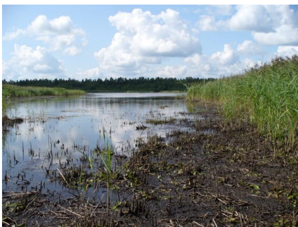
Рис. 1. Затопленная площадка МЗТП. 24.07.2014.
